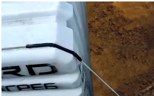
Рисунок 5. Заделка троса
